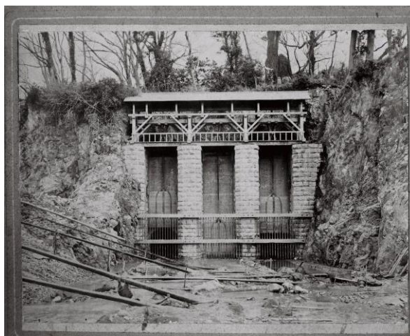
写真1 竣工時の七ヶ用水大水門
